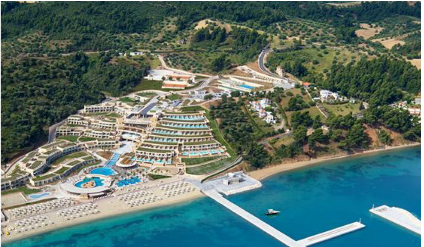
Miraggio Thermal Spa, Kanistros, Greece
