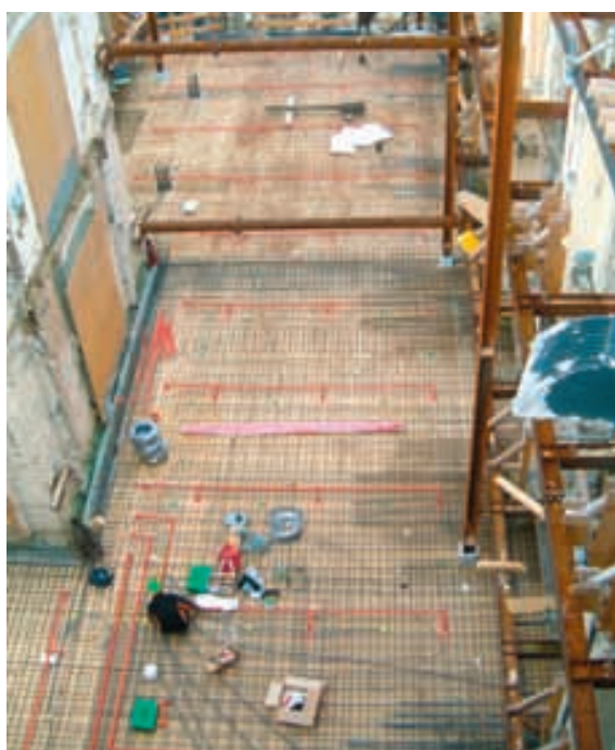
В новых перекрытиях здания прокладываются трубы firestop...
