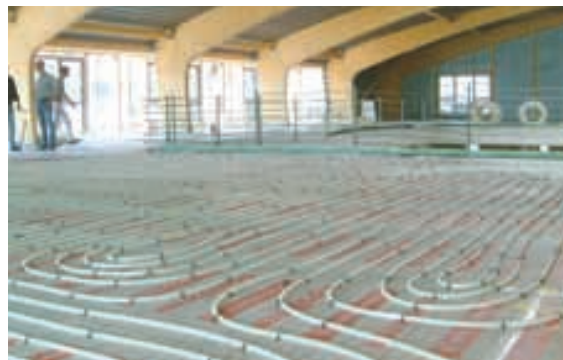
MAX-FITNESS-CENTER, укладка тёплого пола...
