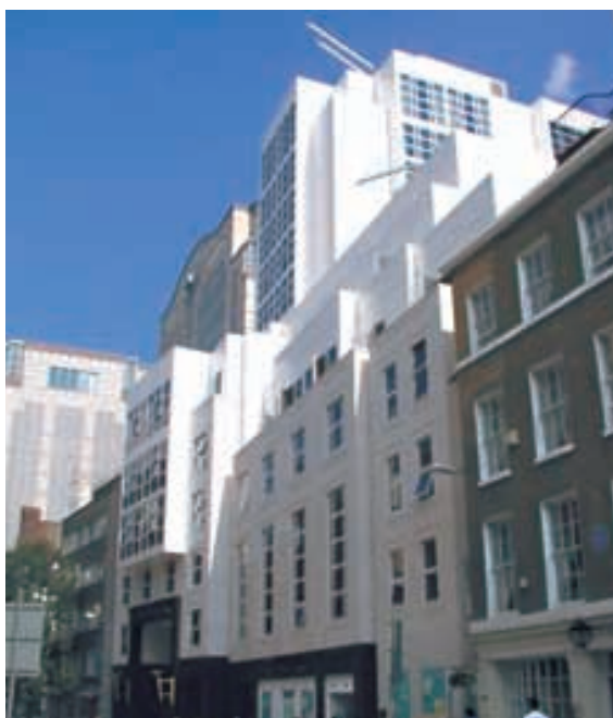
Гостиница Grange City в Лондоне, Англия, сенсационная 5-ти звёздочная люксовая гостиница, оснащённая спринклерной трубопроводной системой «aquatherm»
