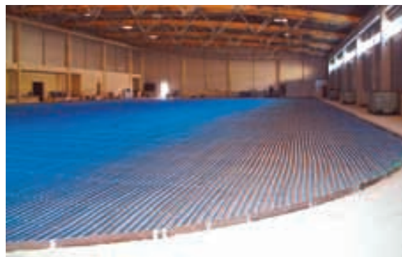
Ледовый каток, г. Зонненберг, Германия (охлаждение выполнено из труб climatherm)
