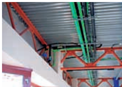
MILLENNIUM STADIUM, монтаж под крышей
