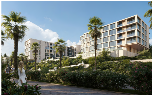
Жилой комплекс «Многофункциональный комплекс Парк» — г. Сочи
