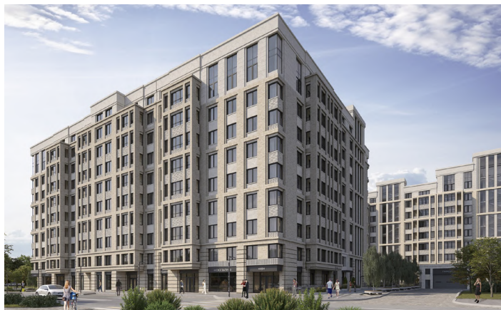
Жилой комплекс «Александровский сад» — г. Екатеринбург
