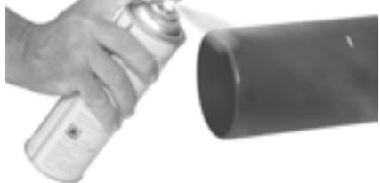
Вставляемая часть трубы также обрабатывается силиконовой смазкой.
