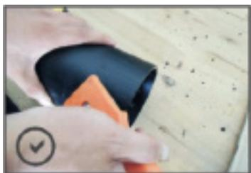
Снимите фаску (прибл. 0.2 мм) и пометьте глубину вставки второй трубы
