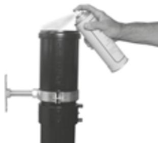
Кольцевое уплотнение раструба компенсационного патрубка обрабатывается силиконовой смазкой.
