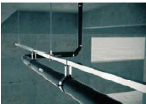
3. Это создает дополнительный подсос дождевой воды с кровли через воронки, оснащенные воздухоотсекателями.
