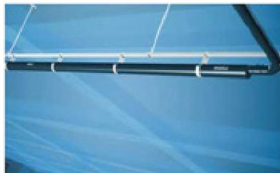
4. Трубопроводы системы предназначены для работы с полностью заполненным сечением, что позволяет применять меньший диаметр, это ведет к уменьшению стоимости системы.
