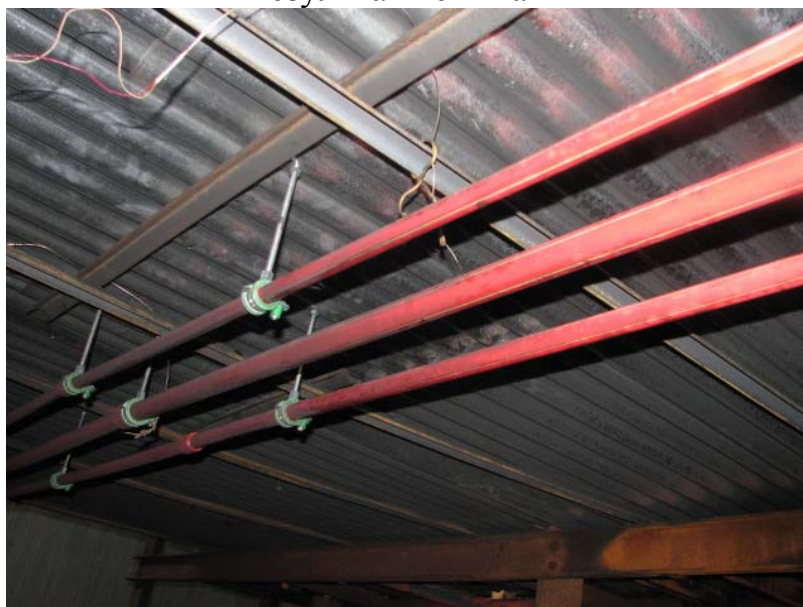
Рисунок ПЕ4 Испытание № 1 ороситель СВН-12, диаметр МОП – 720 мм, монтажное положение оросителей – розеткой вниз, расстояние от розетки оросителя до МОП – 2750 мм; объем бен- зина – 2,5 л
