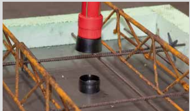
Верхняя часть спринклерного соединительного элемента с отрезком трубы и переходником вставляется в нижнюю часть спринклерного соединительного элемента.
