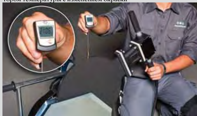
Измерение температуры на сварочной машине aquatherm- для сварки встык
