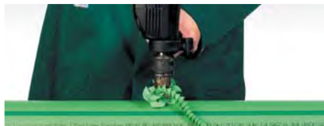
Просверливание отверстия в стенке трубы
