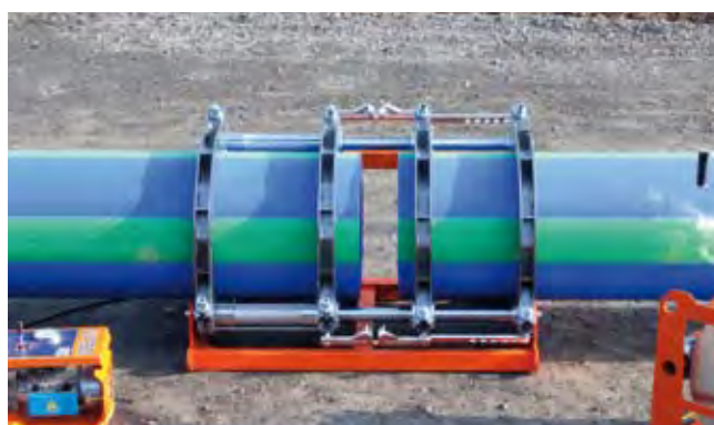
Трубы развести и изъять нагревательный элемент
