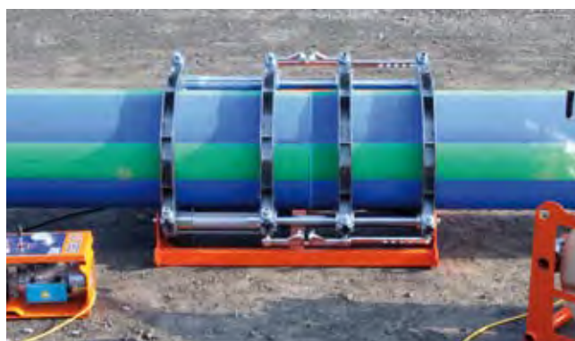
Трубы свести, под давлением оставить остывать
