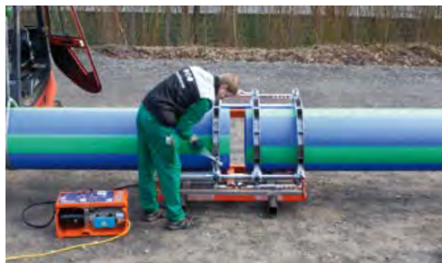
Свариваемые части закрепить, выровнять и зафиксировать
