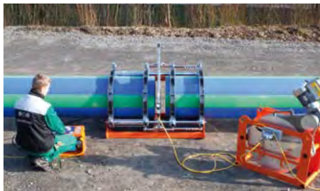
Вствление нагревательного элемента
