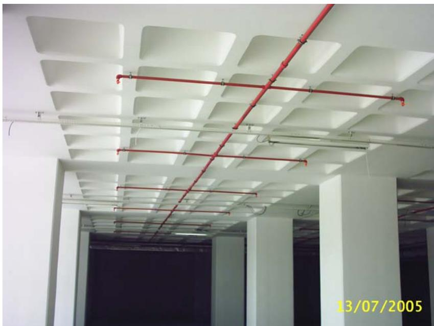
Рисунок 4.1 – Пример монтажа трубопроводов
